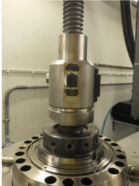
Figur 54 - Montering av drivmutter i drivdonsverkstaden på Forsmark 1.
