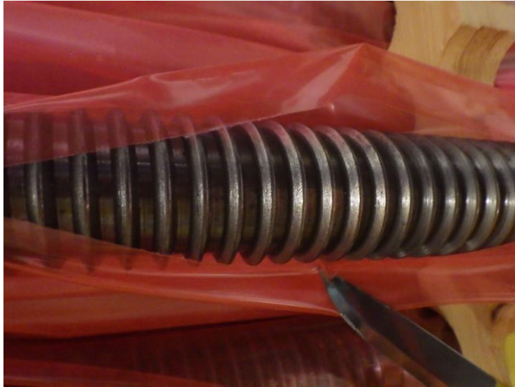
Figur 52 - Närbild på en drivdonsskruv som är sliten och som har gått på säkerhetsgängen.
